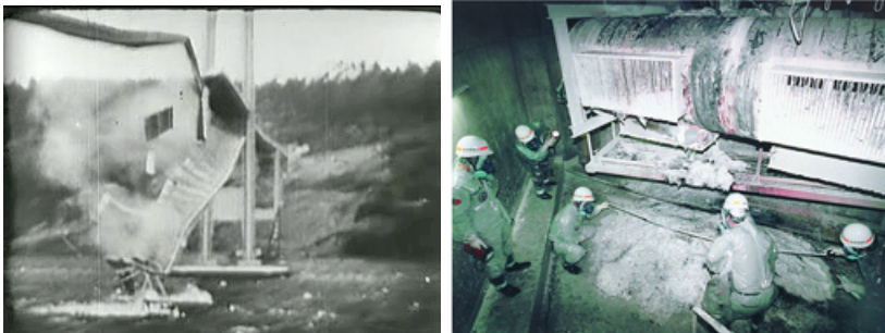
図 1.13 上：タコマ橋の倒壊。下：原子炉もんじゅの事故現場。
